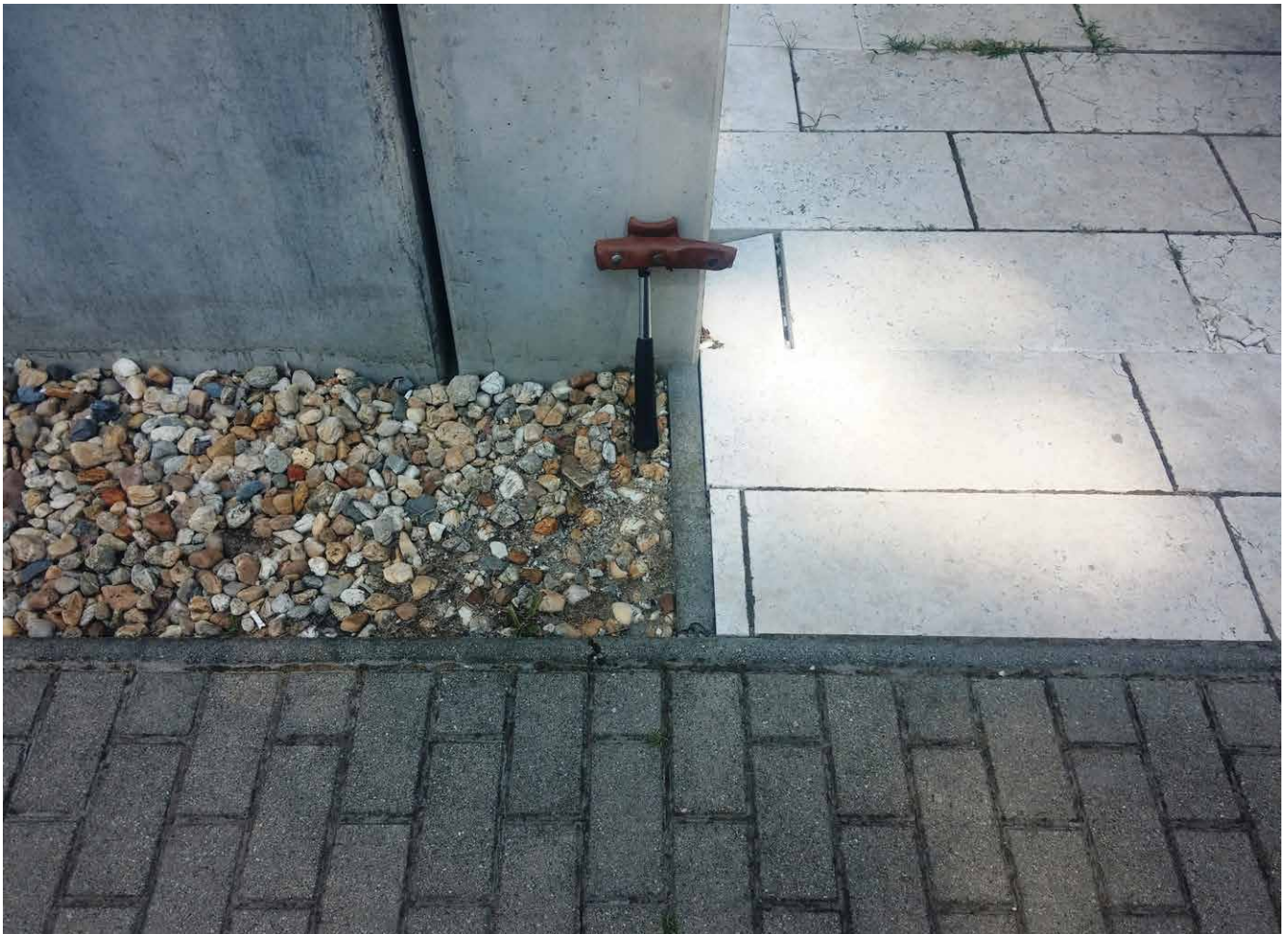
2. ábra: Antropokőzet-típusok: kulé kavics (antropokinetikus kőzet), mellette tömött mészkő járólapok (antropotechnikai kőzet), előtte műkő térkő, mögötte simított betonfal (mindkettő antropogén kőzet) a Debreceni Egyetem Élettudományi Központjának épületénél.
